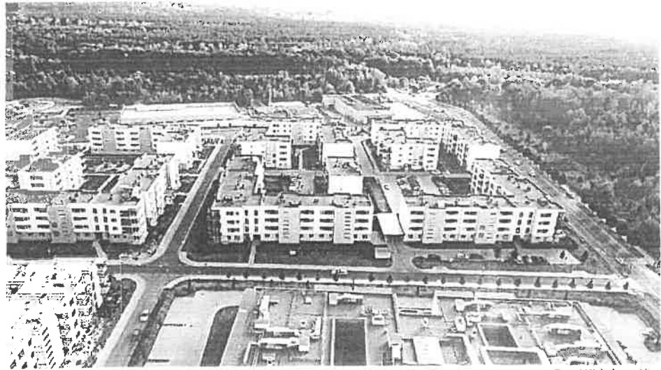
Fot. Widok ogólny
