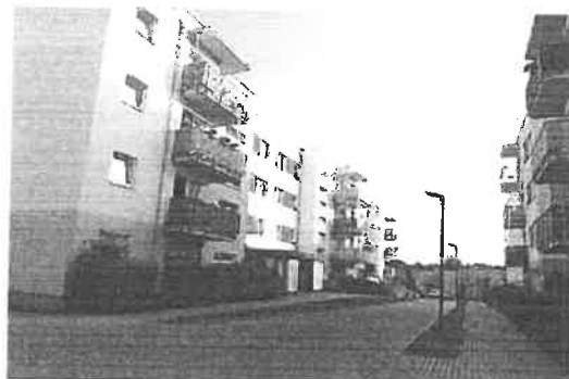
Fot. Widok ogólny
