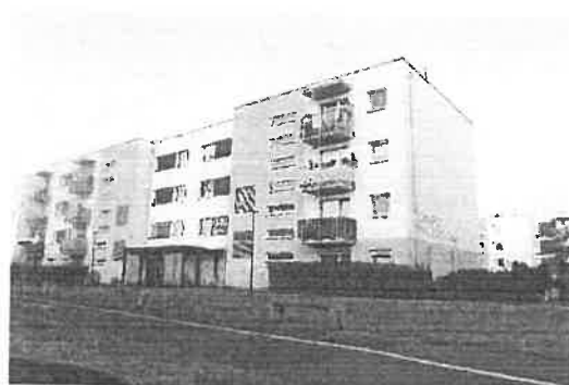
Fot. Widok ogólny
