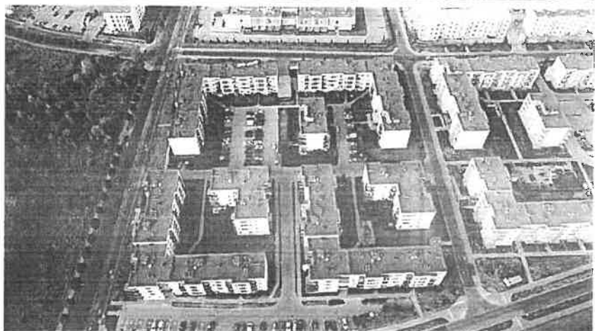
Fot. Widok ogólny
