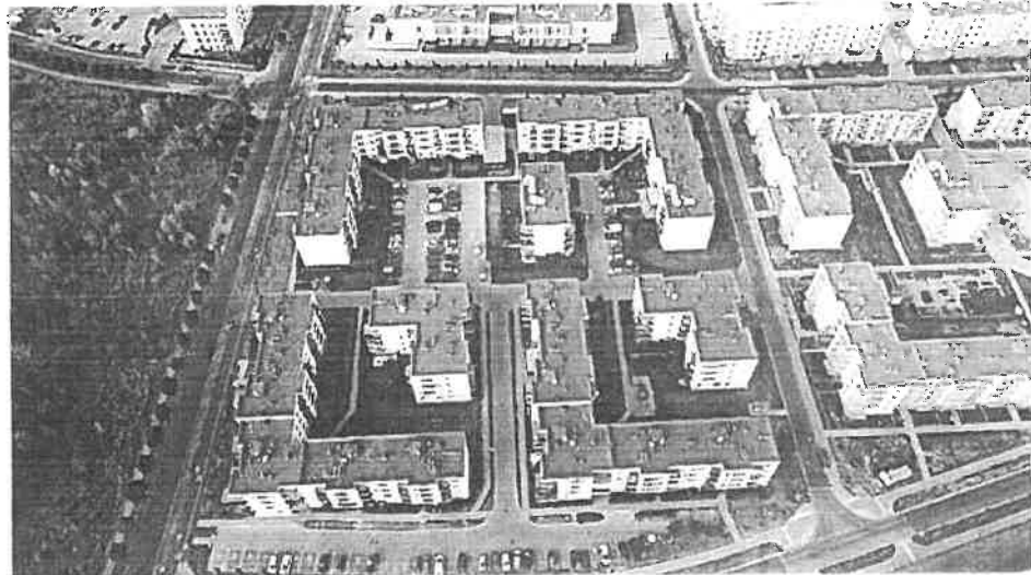
Fot. Widok ogólny
